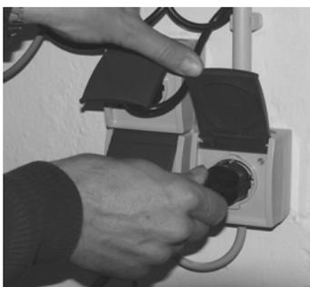
5. Inserire il cavo di allacciamento del motore della pompa nella presa.
