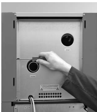
Fig. 43 - Togliere le viti dalla parete posteriore (6).
