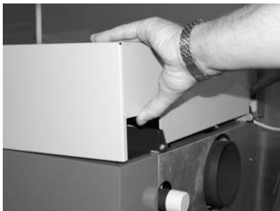
Fig. 50 - Sollevare il coperchio del mantello dietro.
