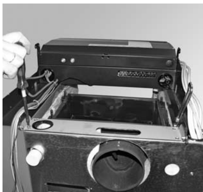
Fig. 27 - Smontare l'angolare di fissaggio.
