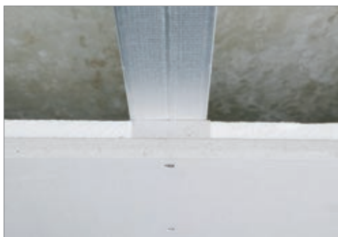
Fig. 8-5 Fissaggio degli elementi a soffitto
