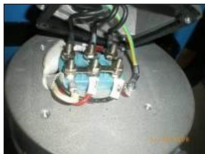
**Collegare il cavo motore dell'interruttore secondo lo schema elettrico del motore idraulico.**
