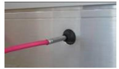
Sul lato del collettore terminale si trova il foro, con guarnizione in gomma, in cui inserire la sonda di temperatura
