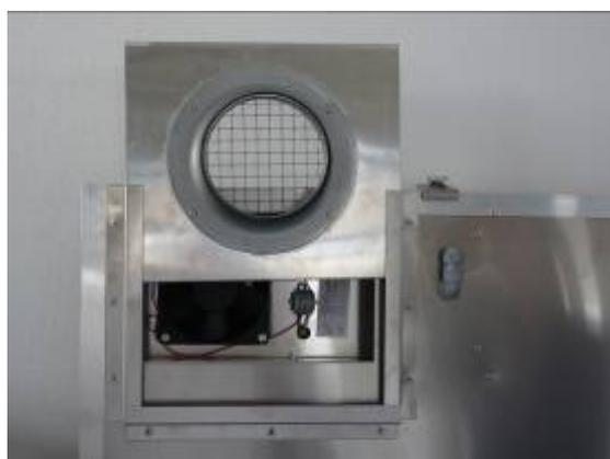
Terminata l'installazione del collettore il kit GTW 110 sarà raccordato ad una canalizzazione aria. Sarebbe quindi impossibile effettuare la sostituzione del filtro. Questo è il motivo per cui deve essere rimosso.
