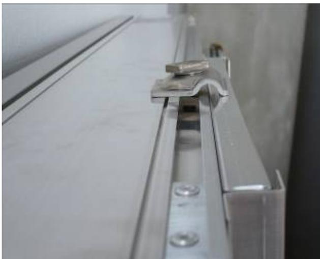
Il telaio contenente il filtro è inserito nelle apposite guide e fissato al collettore tramite una morsa (visibile nella fotografia)
