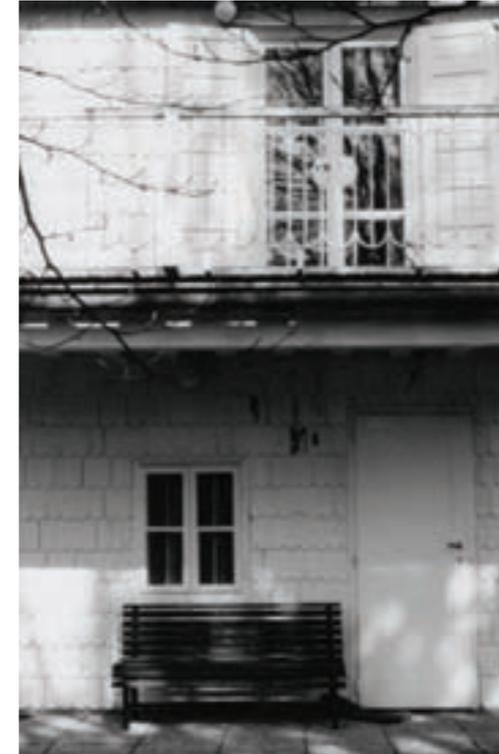
Dettaglio delle scandole in legno sui lati sud ed ovest (fotografia su gentile concessione di Iris Meder) e della committitura delle travi orizzontali sui fronti nord ed est. Muratura sotto al velo di intonaco del camino, da I.Meder 2008 p.35
