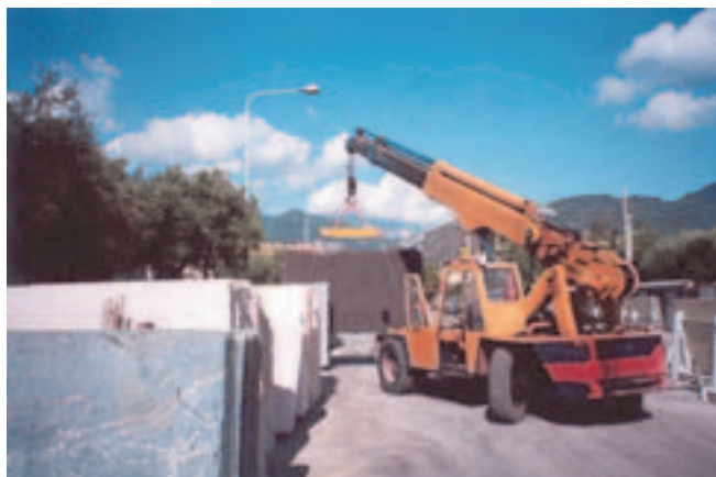
Fig. n. 28: Trasporto lastre con bilancino
