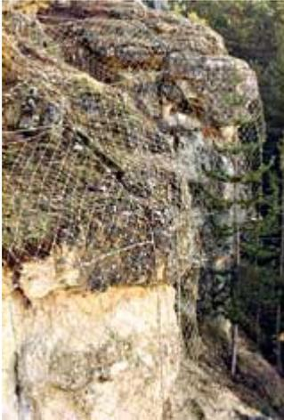
Il lavoro consiste nel rinforzo delle zone rocciose mediante la messa in opera di rete metallica esagonale a doppia torsione con rinforzo mediante reticolo di armatura in funi di acciaio poste diagonalmente e passanti in appositi anelli passacavo posti su barre d'acciaio in perforazioni armate.
