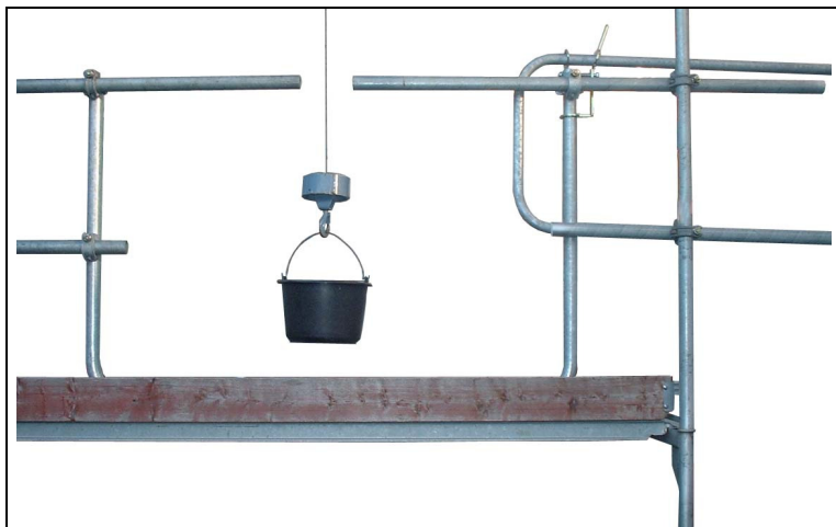
Fig. 14 Sicurezza dei punti di carico - scarico
