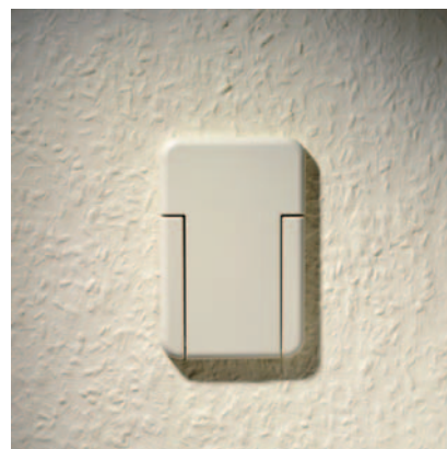
Fig. 5-4 Preso di aspirazione installata
