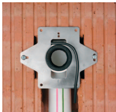
Fig. 5-35 Supporto di montaggio installato e cavo di comando
