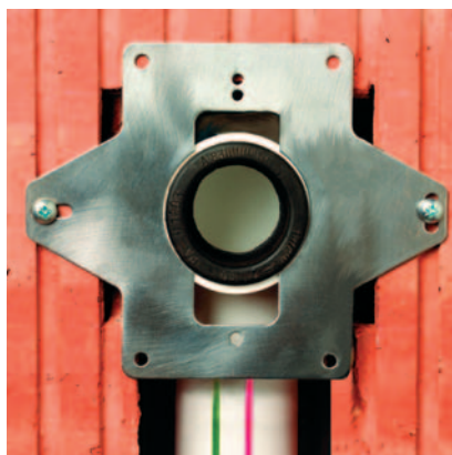
Fig. 5-2 Supporto di montaggio installato
