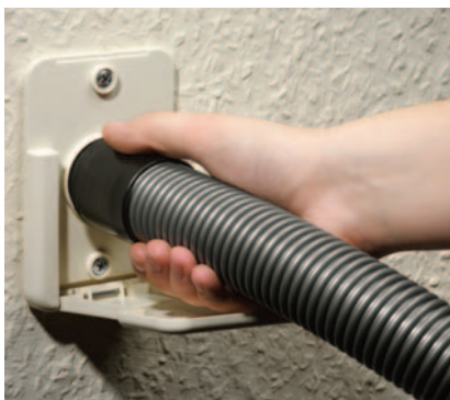
Fig. 1-2 Collegamento del tubo flessibile di aspirazione
