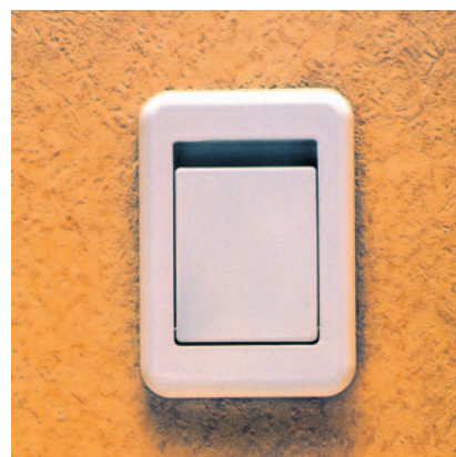
Fig. 5-37 Presca di aspirazione installata
