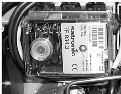
**SÖ-NT: Sblocco del dispositivo automatico di controllo bruciatore**
