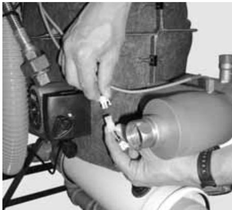
Fig. 5-14 Allentare lo spinotto per la sonda di temperatura fumi
