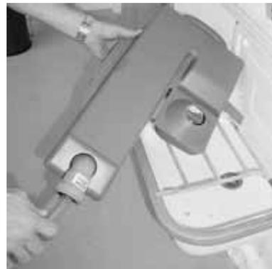
Fig. 8-7 Lavaggio del tubo di scarico condensa
