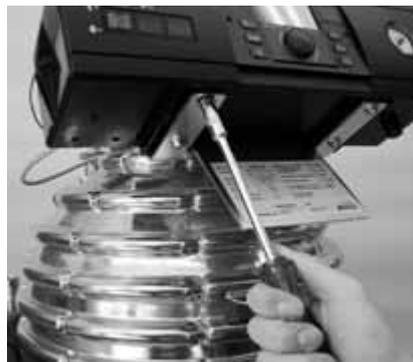
Fig. 5-9 Allentare le viti di fissaggio del quadro di comando della caldaia
