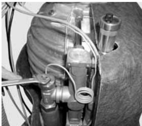
Fig. 5-4 Rimozione del tubo capillare del manometro
