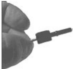
La fibra deve sporgere dalla punta del connettore di max. 1–1,5mm (se necessario, accorciare la fibra utilizzando delle forbici o un coltello affilato).
