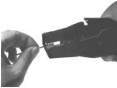
Togliere il rivestimento del conduttore simplex su almeno 3mm utilizzando una pinza spelafili.
