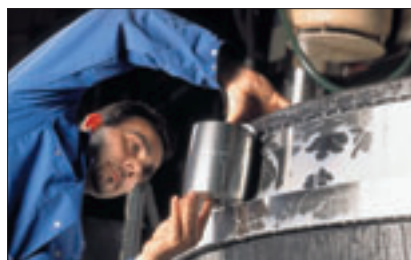
Controllo dell'alloggiamento dei rulli
