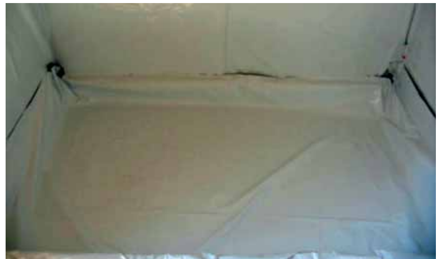
Dopo aver fissato alle pareti la plastica bianco-nera, attacchiamo lo stesso telo bianco-nero alla nostra costruzione. Così facendo abbiamo realizzato una semplice vasca di raccolta. Attenzione agli oggetti appuntiti che potrebbero bucarla.
