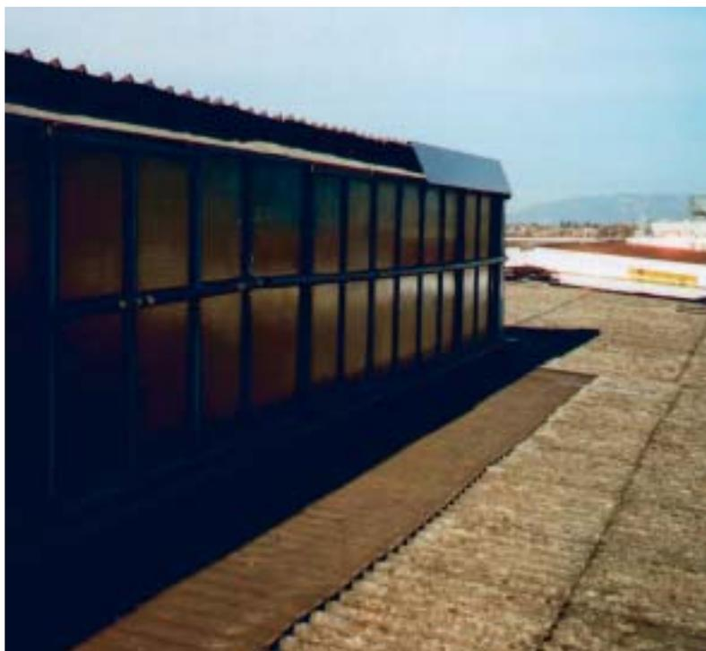
*Protezione delle aperture verticali (Shed)*
