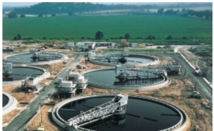
In impianti per il trattamento delle acque reflue
