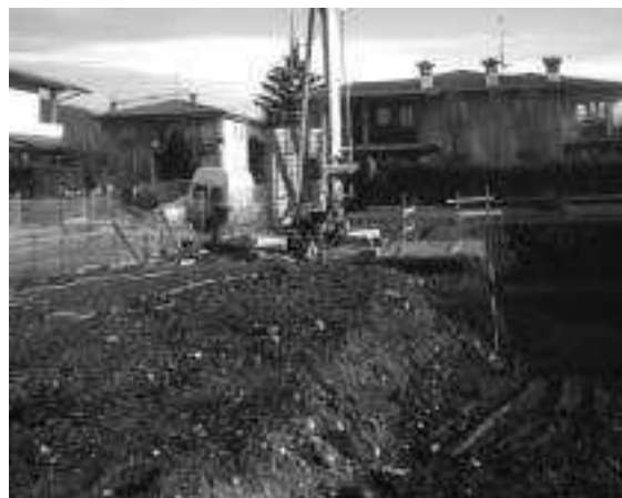
Attenzione alla consistenza della parete dello scavo
