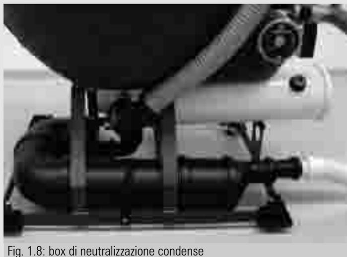
Fig. 1.8: box di neutralizzazione condense
