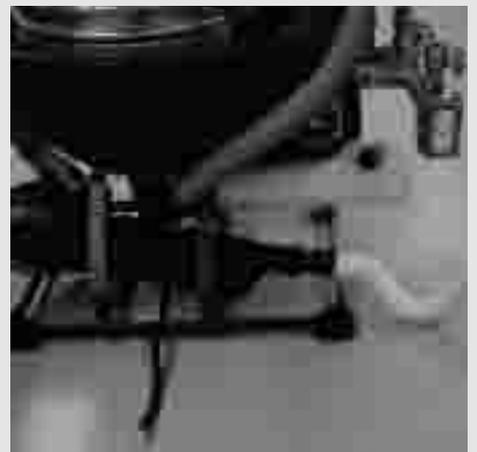
Fig. 7.11: svuotamento tubo di neutralizzazione
