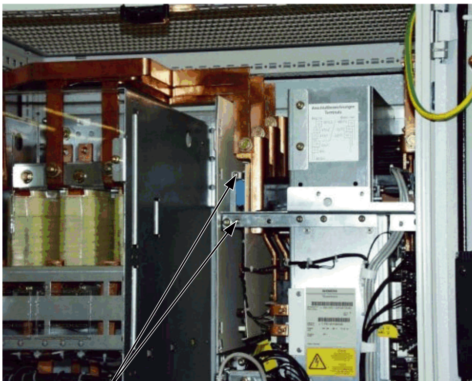
Figura 4-4 Rimozione della staffa di collegamento del condensatore antidisturbi
