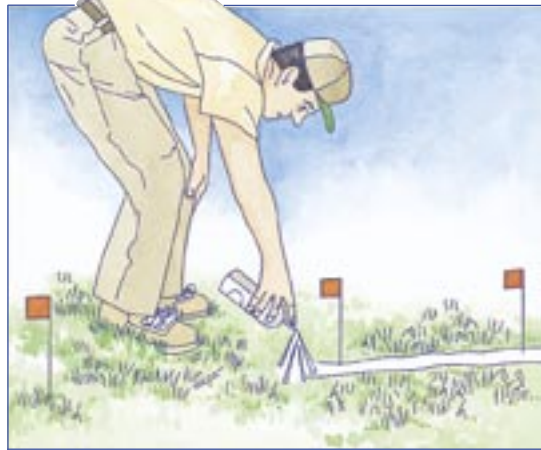
Prima di eseguire la trincea marcare il tracciato dell'impianto di innaffiamento utilizzando delle bandierine ed una bomboletta di vernice.
