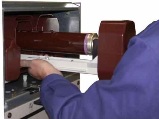
**Sostituzione dei fusibili HRC** In caso di intervento di un fusibile HRC, sostituirlo sempre per tutte le tre fasi.
