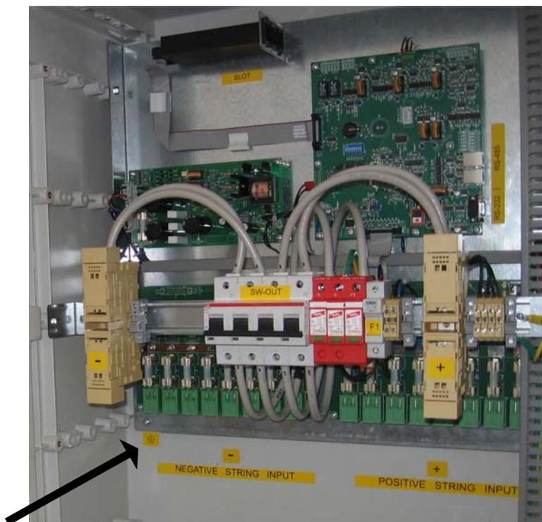
Connessione del cavo di terra
