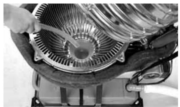
Fig. 5-10 Riempimento del dispositivo di trattamento della condensa dalla caldaia
