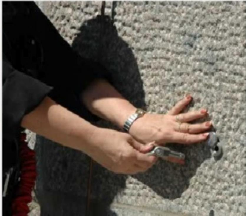
**Figure 4-5:** Applicazioni Pratiche. L'estraibilità del punto di ancoraggio e la trasportabilità dello stesso lo fa assimilare ad un DPI quindi la parte estraibile deve essere marcata CE
