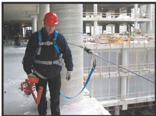
Fig 2 – Utilizzazione con ancoraggio ad elementi strutturali
