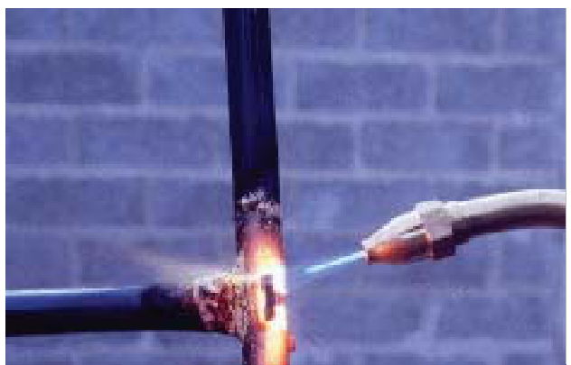
Figura 4.4 Costruzioni - Uso di una torcia per saldature silenziosa © Yves Cousson – Gentile concessione di INRS - Francia
