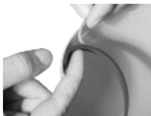
Installation der Dichtung
