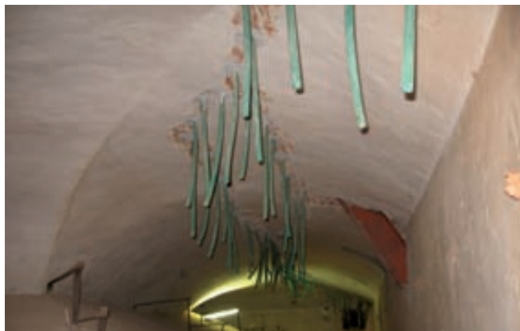
Cantiere restauro complesso museale Uffizi Firenze
