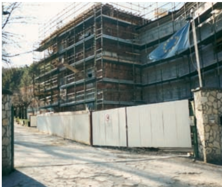
Cantiere Bagni di Nocera Umbra
