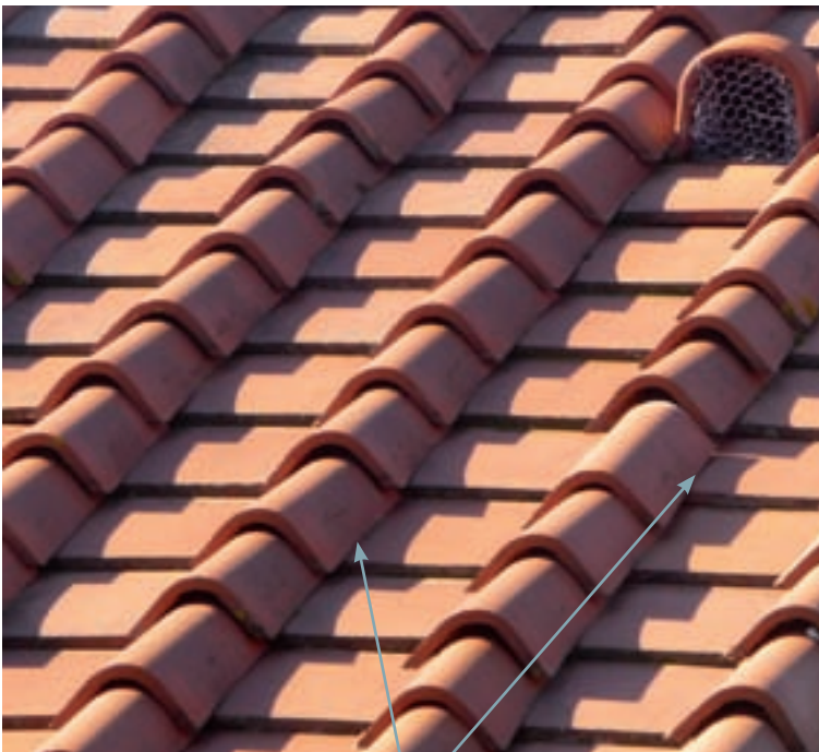
Tetto toscano C Il tegolo aderisce sull'embrice, ma non poggia sul tegolo inferiore e può scivolare, come sono scivolati alcuni in questa foto
