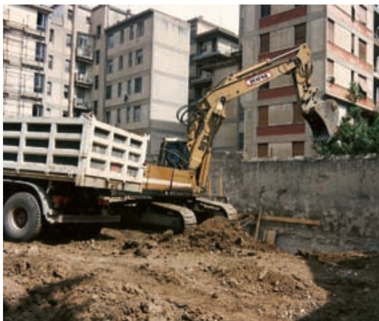
Cantiere nuova sede Unipol Firenze
