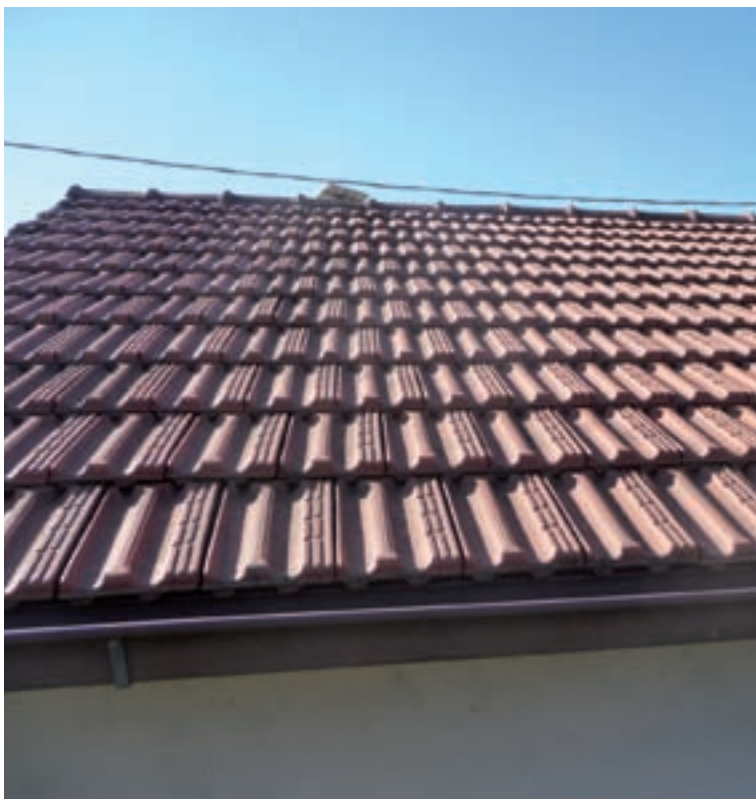
Esempio di copertura con marsigliesi
