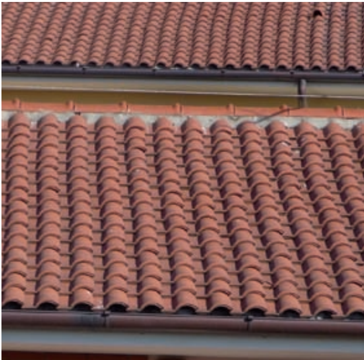
Esempio di copertura con portoghesi
