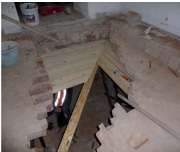
Cantiere restauro Complesso museale Uffizi Firenze
