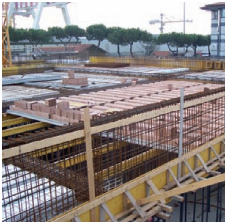
Cantiere Autorità portuale Marina di Massa
