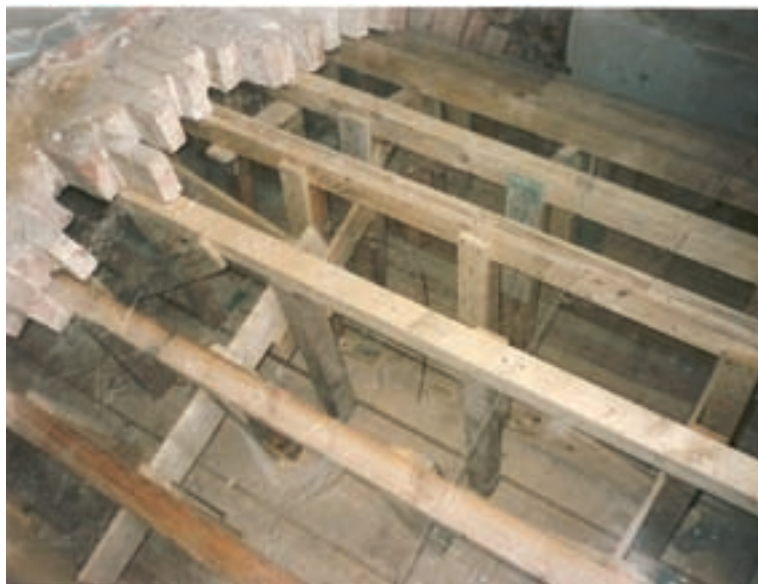
Cantiere restauro museo Santa Maria della Scala Siena
