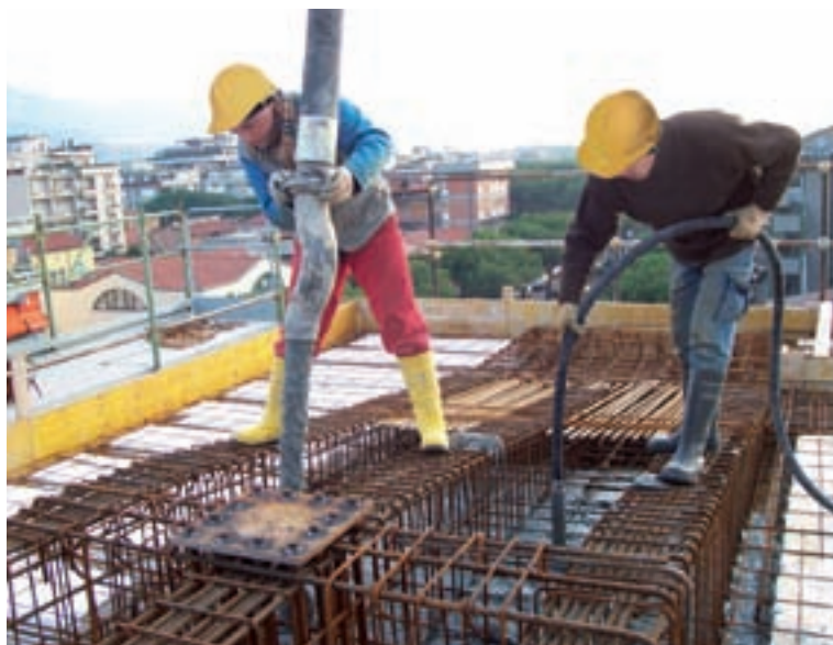
Cantiere Autorità portuale Marina di Massa
