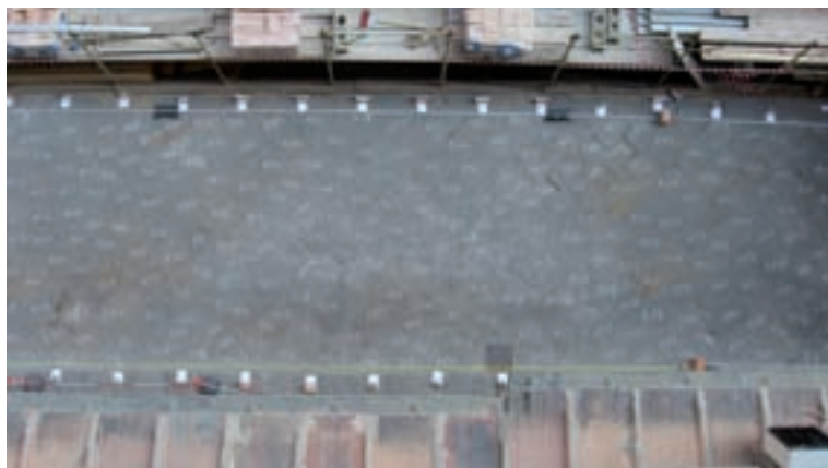
Cantiere restauro complesso museale Uffizi Firenze
