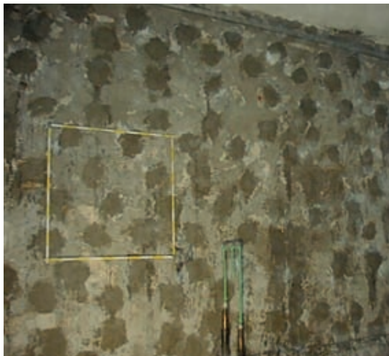
Cantiere Bagni di Nocera Umbra
