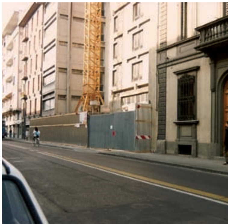
Cantiere nuova sede Unipol Firenze
