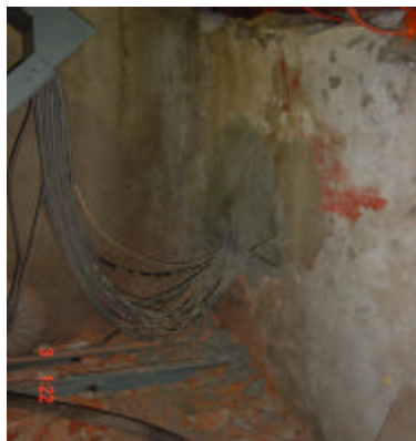
Foto 6 – Fascio cavi elettrici
