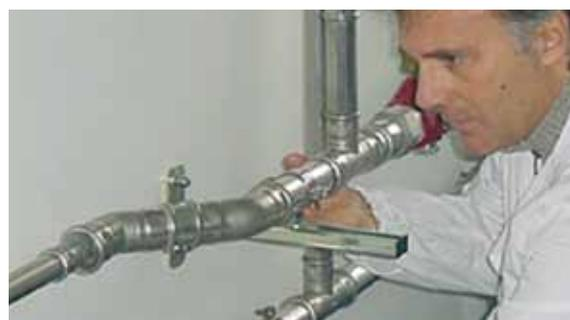
**Figura 23** - Controllo della pressatura
