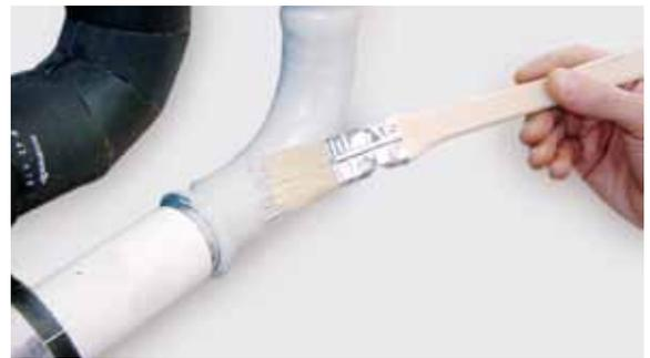
Figura 24 - Verniciatura raccordi e tubazioni con primer.
