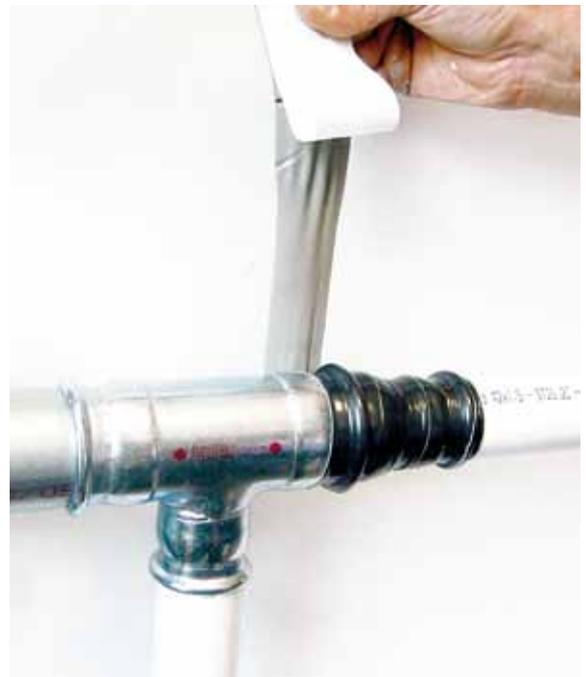
Figura 25 - Protezione dei raccordi con nastro isobutilico cod. 850NS000000 (senza verniciatura con primer).
