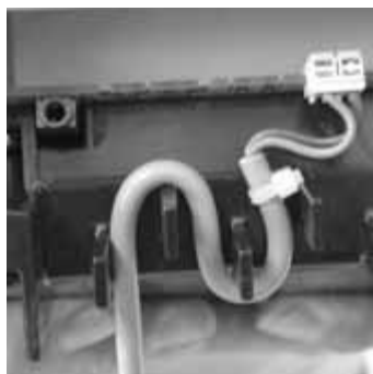
Figura 3-27 Fase di lavoro 2
