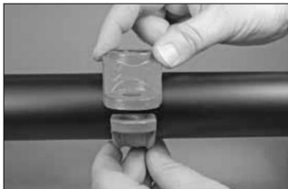
**3. INSTALLARE I GUSCI:** installare il guscio con il foro d'uscita sul tubo inserendo il collare di posizionamento al centro del foro. Per verificare se l'inserimento è corretto, far scorrere il guscio della derivazione in avanti e all'indietro, premendolo contemporaneamente sul tubo. Se il guscio è inserito correttamente può spostarsi solo leggermente in tutte le direzioni.
