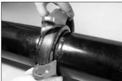
7. **INSTALLARE I GUSCI:** installare i gusci sopra la guarnizione. Assicurarsi che i risalti dei gusci si innestino correttamente nelle scanalature su entrambi i tubi/componenti di raccordo.
