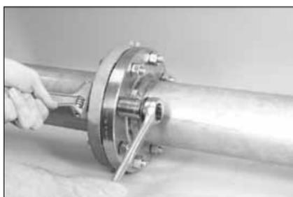
**8. INSTALLARE I BULLONI/ DADI RIMANENTI:** inserire un bullone di collegamento standard con diametro a tutto stelo in ogni foro ancora libero della flangia di accoppiamento e l'adattatore Vic-Flange. Serrare i dadi su ciascun bullone solo con le mani.
