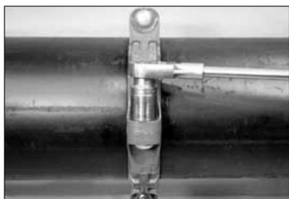
**4. SERRARE I DADI:** i dadi vanno serrati tutti in modo uniforme, a lati alterni, fino a che non vanno in battuta, metallo contro metallo, sulle teste dei bulloni. Verificare che i risalti dei gusci si inseriscano perfettamente nelle scanalature. **NOTA:** per evitare il pizzicamento della guarnizione, è importante serrare in modo uniforme tutti i dadi.
