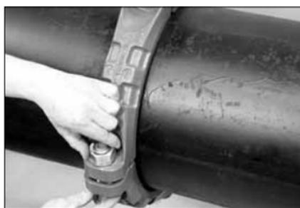
**3a. INSTALLARE IL RIMANENTE GRUPO DI SEGMENTI:** installare sul tubo il secondo gruppo. Assicurarsi che i risalti dei gusci s'innestino completamente nelle scanalature su entrambe le estremità dei tubi. Sostenendo il peso del gruppo, installare gli altri bulloni e avvitarsi sopra i dadi, solo con le mani. **NOTA:** accertarsi che il colletto ovale di ciascun bullone alloggi correttamente nell'apposito foro.
