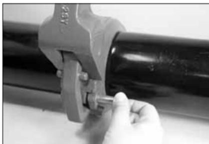
**5. INSERIRE IL PERNO DI BLOCCAGGIO:** verificare la corretta misura del perno di bloccaggio (consultare la tabella su questa pagina). Montare il perno inserendo l'estremità piatta del perno nel foro.
