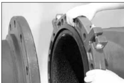
**6. ALLINEARE FLANGIA DI ACCOPPIAMENTO E VIC-FLANGE:** ruotare la flangia Vic-Flange sull'estremità del tubo fino a che i fori non risultino allineati con quelli della flangia di accoppiamento.
