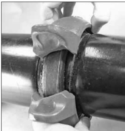
7. **INSTALLARE I GUSCI:** installare i gusci sopra la guarnizione. Assicurarsi che i risalti dei gusci si innestino correttamente nelle scanalature su entrambi i tubi/componenti di raccordo.
