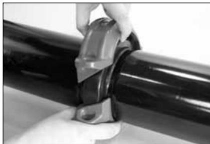
3. **INSTALLARE I GUSCI:** utilizzare la funzione di "oscillazione" per installare i gusci sulla guarnizione. Assicurarsi che i risalti dei gusci s'innestino completamente nelle scanalature su entrambe le estremità dei tubi.
