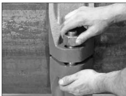
**6. INSTALLARE I GUSCI:** installare i gusci sopra la guarnizione. Assicurarsi che i risalti dei gusci entrino completamente nelle scanalature su entrambe le estremità dei tubi o AGS Vic-Ring. Durante la preparazione dei bulloni e dei dadi prevedere un adeguato sostegno per i segmenti.
