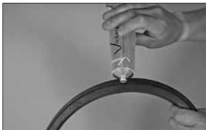
2. **CONTROLLARE LA GUARNIZIONE E LUBRIFICARE:** controllare la guarnizione verificando che sia adatta alla destinazione d'uso prevista. Il codice colore identifica il grado della guarnizione. Applicare uno strato sottile di lubrificante Victaulic o di un lubrificante a base di silicone sull'esterno e sui bordi della guarnizione.
