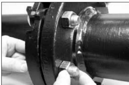
**7. INSTALLARE I BULLONI/ DADI RIMANENTI:** inserire un bullone di collegamento standard con diametro a tutto stelo in ogni foro ancora libero dell'adattatore per flange o nella flangia corrispondente. Avvitare i dadi flangiati standard su tutti i bulloni, solo con le mani.
