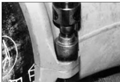
**4. SERRARE I DADI:** i dadi vanno serrati tutti in modo uniforme, a lati alterni, fino a che si realizza il contatto metallo contro metallo alla testa dei bulloni. Verificare che i risalti dei gusci s'inseriscano perfettamente nelle scanalature. **NOTA:** per evitare il pizzicamento della guarnizione, è importante serrare in modo uniforme tutti i dadi.
