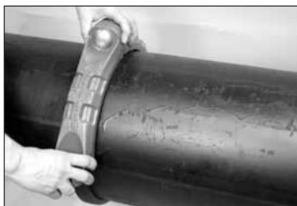
**3. INSTALLARE IL PRIMO GRUPPO DI SEGMENTI:** installare sulla guarnizione una delle metà premontate. Assicurarsi che i risalti dei gusci s'innestino completamente nelle scanalature su entrambe le estremità dei tubi.
