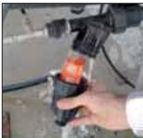
Il filtro posto sul collettore d'ingresso fornisce l'acqua necessaria al comando idraulico delle valvole e del manometro differenziale. E' necessario pulirlo periodicamente per evitare malfunzionamenti delle valvole a solenoide. Svitare il coperchio del filtro posto sul fondo o sul fianco del collettore. Estrarre la massa filtrante e lavarla accuratamente. Pulire il coperchio e l'interno del filtro con un getto di acqua pulita. Reintrodurre la massa all'interno del corpo filtro, pre-
