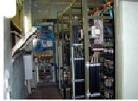
*interno di cabina elettrica sprovvisto di segregazione delle parti in tensione*
