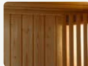
Le pareti e il soffitto in legno di abete da 58 mm di spessore riflettono il calore senza bisogno di ulteriore isolamento e con un minimo impiego di materiale.
