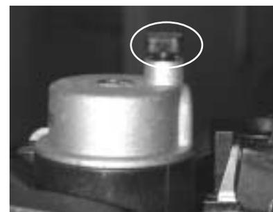
**4** Aprire il rubinetto blu di riempimento posizionato sotto la caldaia fino a leggere 1,2 bar sull'indicatore della pressione.
