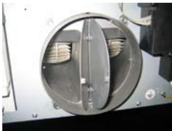
In caso di impianto con scarico all'esterno, l'installazione della valvola di non ritorno impedisce l'entrata di vento e i ritorni d'aria
