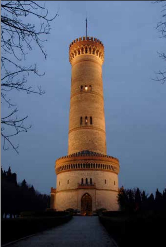
Torre di San Martino della Battaglia
