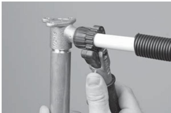
Überwurfmutter mit dem Ratschen-Drehmomentschlüssel (Art. Nr. 4832) anziehen. Zum Gegenhalten Richthülse (Art. Nr. 5777) oder Konterschlüssel (Art. Nr. 4834) verwenden.
