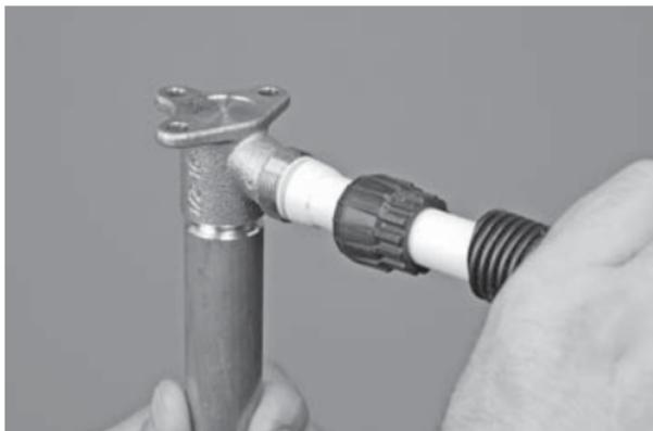
Aufgebördeltes JRG Sanipex MT Rohr auf den JRG Sanipex MT Fitting stecken. Überwurfmutter handsatt anziehen.
