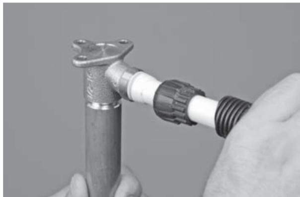
Innestare il tubo JRG Sanipex MT allargato nel raccordo JRG Sanipex MT. Stringere forte a mano il dado di chiusura.
