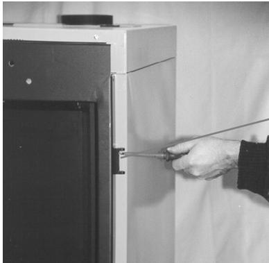
➤ Montare la cerniera con viti a testa svasata (2x2 M5x20) sulla caldaia
