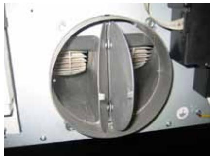
Dans le cas d'une installation en évacuation extérieure, l'installation du clapet anti-retour empêche l'entrée du vent et le retour d'air.
