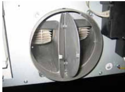
La instalación de la válvula de no retorno impide la entrada de viento y el retorno de aire.
