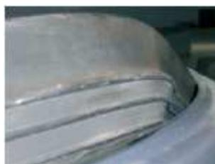
■ Ingrassare la guarnizione slabbrata, poggiare il chiusino, portarlo all'altezza di installazione desiderata e fissarlo con il morsetto ad anella (Art. 860129).
