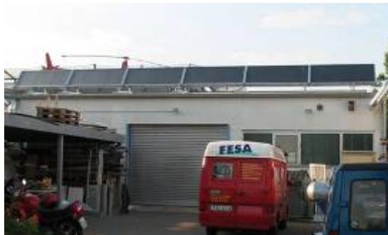
Figura: Impianto standard GLK su tetto piano.
