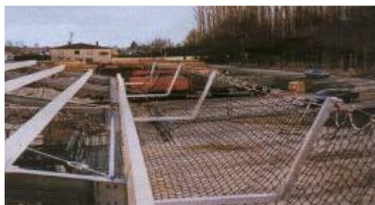
Figura: rete anticaduta montata
