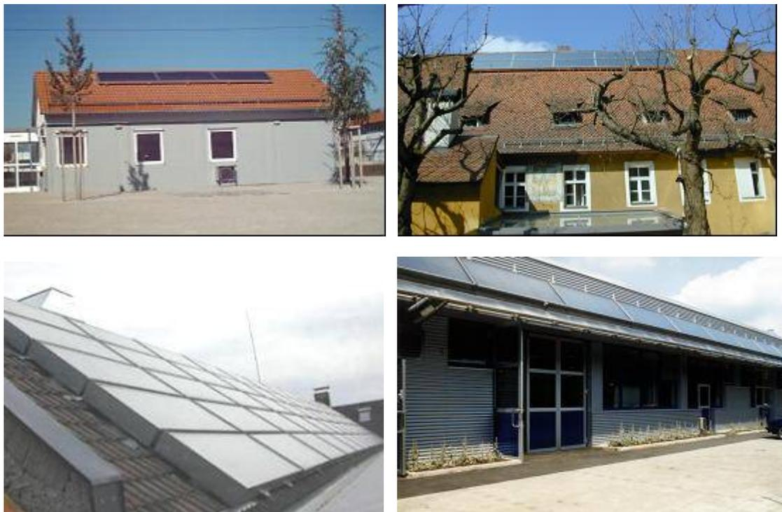
Figure: Esempi di pannelli standard montati su tetti spioventi
