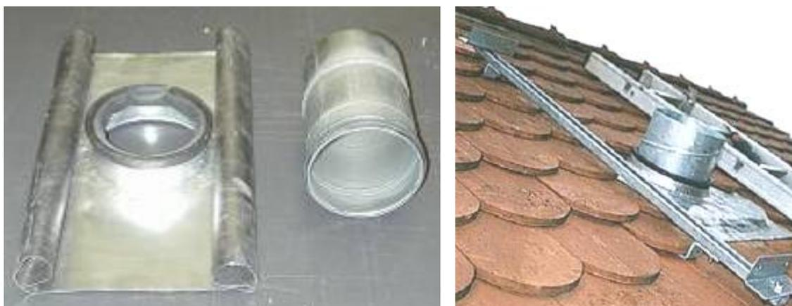
Figure: (sinistra) foro passante per tetto con manicotto sincronizzatore; (destra) dopo il montaggio su tetto a tegole piatte
