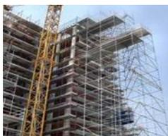
Il ponteggio fisso è un'opera provvisoriale realizzata per eseguire lavori ad altezze superiori ai 2 metri. Si tratta di una struttura reticolare realizzata con elementi metallici.
