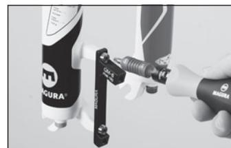
◀ Montate l'adattatore alla forcella o al telaio utilizzando le viti di fissaggio in dotazione. Coppia di serraggio: 6 Nm.
