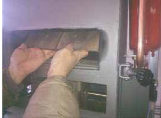
Pulizia del giro fumi superiore e rimozione schienale.
