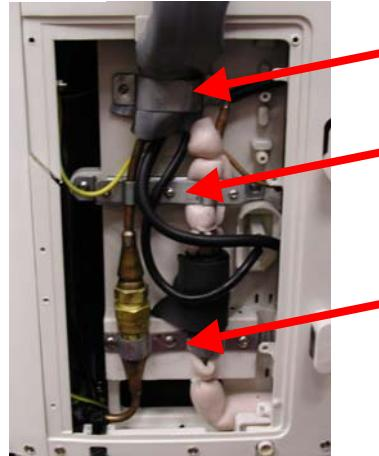
6. Sobald Sie das Aussengerät platziert haben, müssen die Kältemittelleitungen wieder auf gleiche Weise angeschlossen werden.
