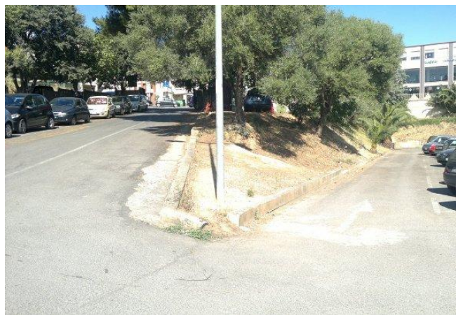
Rampa di accesso all'area (parte interna)
