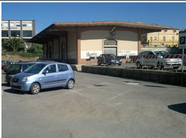
Ex magazzino da ristrutturare
