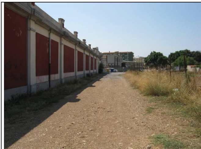
Area nuova strada di accesso
