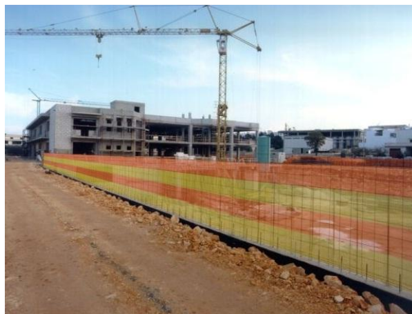
Recinzione metallica di cantiere e telo di protezione
