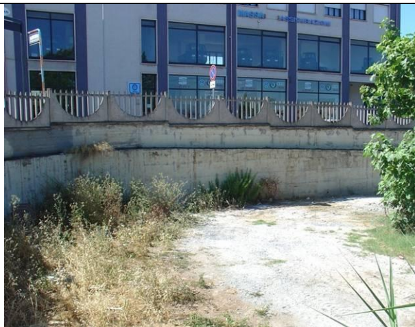
Muro interno sulla Via XX settembre
