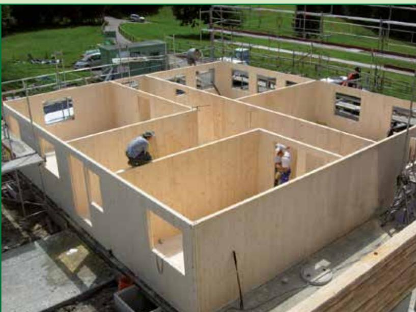
Con i dovuti accorgimenti sotto il profilo dei vincoli statici, l'X-LAM è ad oggi una delle poche tecniche costruttive in legno in grado di permettere la costruzione di edifici multipiano, uscendo dalla concezione tradizionale delle costruzioni in legno ad un unico piano che ne ha nel passato limitato la conoscenza e la diffusione.
