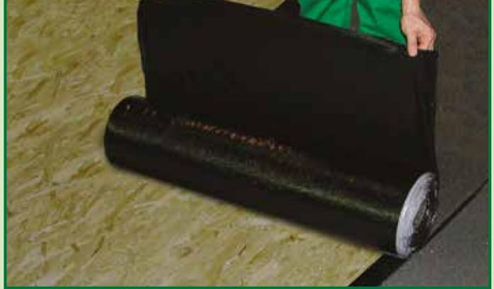
Nella famiglia delle membrane BEST-ADHESIVE, la gamma SELFTENE si distingue perché è costituita da una serie specifica di membrane ed accessori, corredata da apposite istruzioni d'uso, selezionata per una posa semplice, senza impiego di attrezzature professionali e utilizzando una gamma ridotta di prodotti, per la soluzione dei più comuni problemi di impermeabilizzazione dei tetti in legno.
