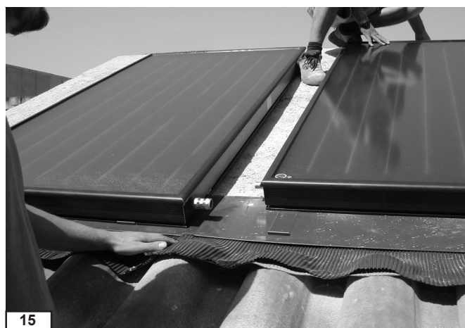
15 Avere cura di agganciarlo alle apposite alette. Effettuare i collegamenti idraulici con i raccordi in ottone.
