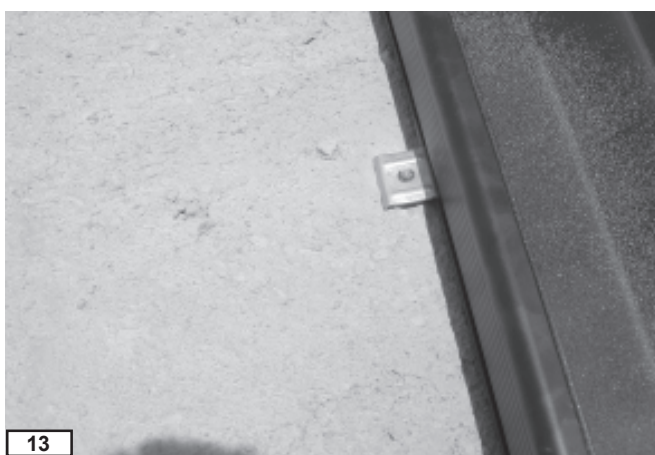
13 Fissarli saldamente alla falda del tetto.
